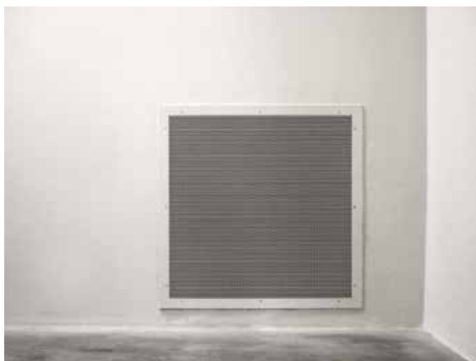
Einbaubeispiel Zuluftgitter für geregelte Luftverteilung
